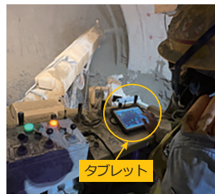
自動吹付け状況
