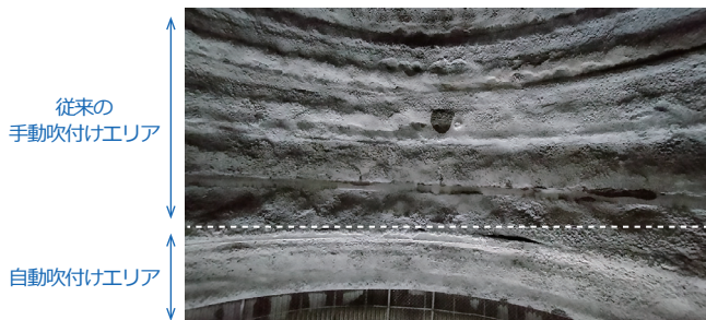
手動吹付けと自動吹付けの仕上がり比較
