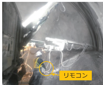
従来の手動吹付け状況
