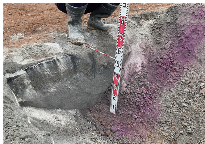
フェノールフタレイン溶液を用いた混合厚さ確認状況
