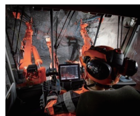
コンピュータジャンボによる削孔状況
