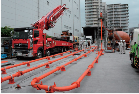
ポンプ圧送状況
