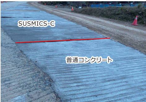
仮舗装コンクリート
