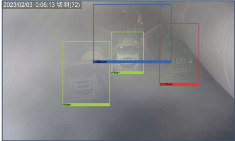
吹付け機、ミキサー車、バックホウを検出
