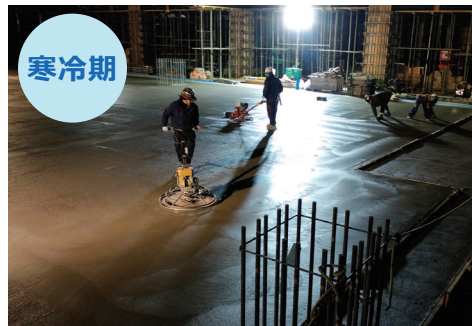
コンクリートの凝結遅延・時間外の作業
