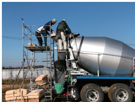
デンカACFを現場投入(2分攪拌)
