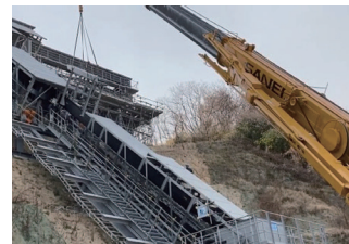
⑨ フレーム撤去状況
