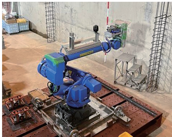
3Dプリンタの設置状況
