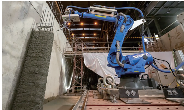
柱部材のプリンティング状況
