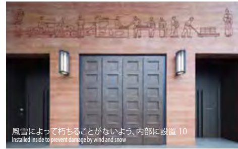
旧本館のランタンと鉄製扉 09 Lanterns and iron eaves at the old Main Building
