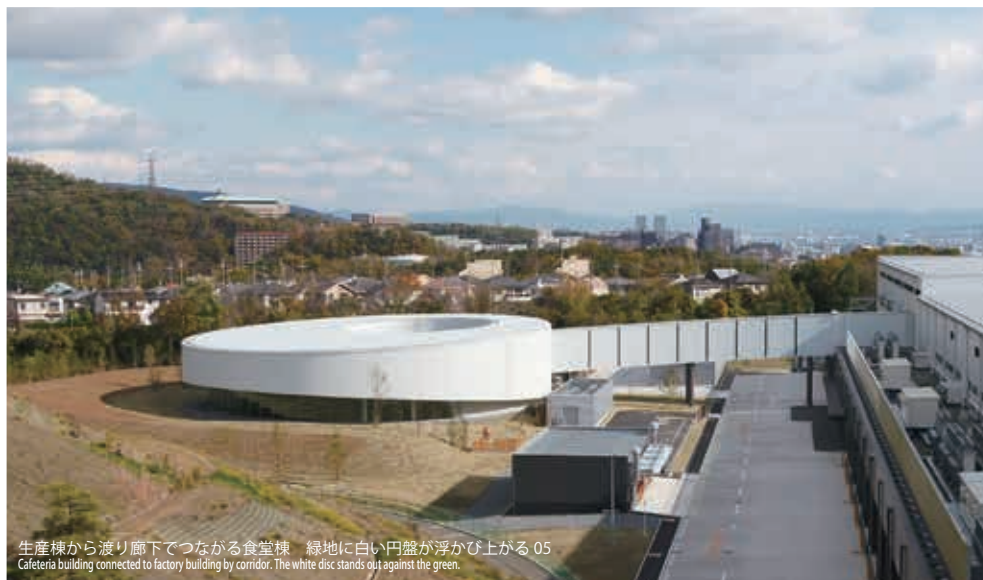
鉄筋コンクリート造の壁と鉄骨トラスにより37mを1スパンとして緑地へのパノラマビューを実現した 04 Reinforced concrete wall and steel truss make the 37-meter span possible, opening up a panorama view to the greenery.
