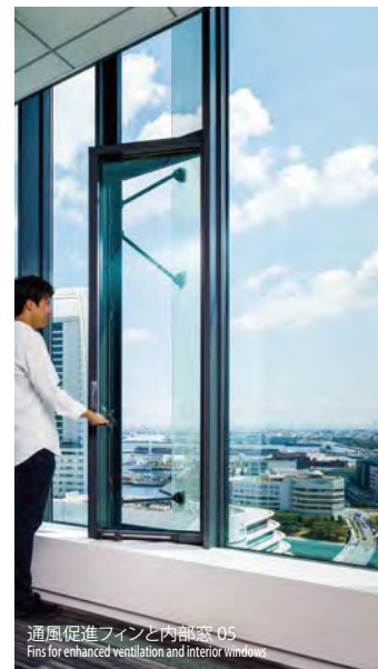
ビルが風を受けた時のファサード面の風圧のゆらぎ、窓毎の風圧差により通風を促進する Fluctuations in wind pressure on facade surface when wind strikes the building
