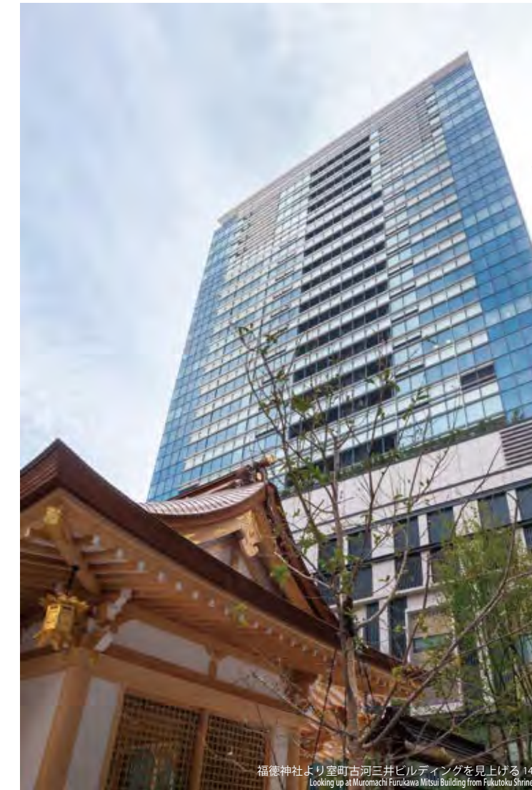
福德神社鳥居と室町古河三井ビルディング 13 Torii of Fukutoku Shrine and Muromachi Furukawa Mitsui Building
