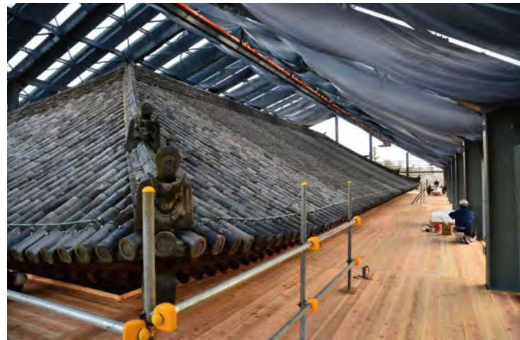
既存本瓦（奈良時代の瓦も多数存在） Existing roof tiles (many tiles date back to the Nara Period)
