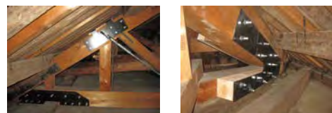
小屋組みの補強 Roof truss reinforcement
