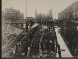
崩落する吾妻橋
