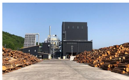
信州ウッドパワー (発電容量2MW)
