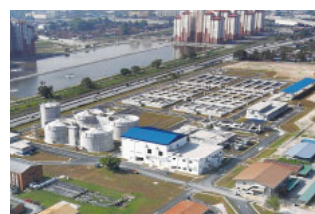
完成間近のマレーシア下水処理場。左端のため池が既設処理場
