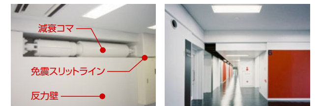
免震部のスリム化に寄与する減衰コマ ※2 は教材として製図室に設置しました オリジナルのパーティションを彷彿させる、階ごとに異なるカラフルな掲示壁を新設
