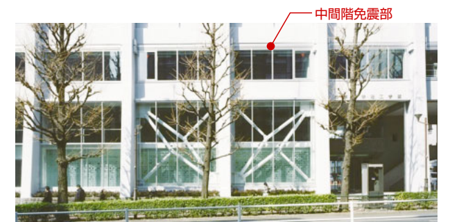
中間階免震部の外観は変化を最小限に抑えました。免震層の下層階は、繊細なディテールのトグルダンパー ※3 で制震補強しました
