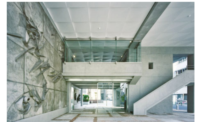
1階ピロティでは2層吹き抜け壁の小野襄作のレリーフが保存されました
